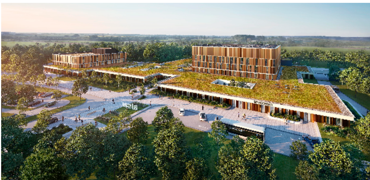
(Aard)gasloos ziekenhuis Meppel: verwarming en koeling met wko. Impressie: Vakwerk Architecten
