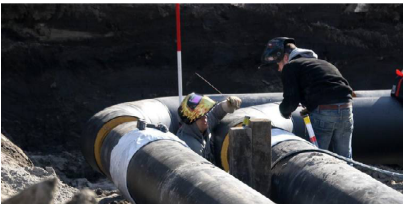
Aanleg warmtenet Bron: Dagblad van het Noorden
